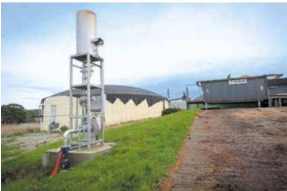
Figure 3 : Exemple de torchère et d'épandage des digestats par « pendillard »
